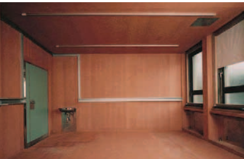
Raum mit atmungsaktiver Schirmungstapete (Dämpfungswerte bis ca. 65 dB)
